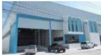
Takahashi Metal Industries(Thailand)Co., Ltd. 新工場
