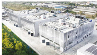
新設した「Giga Data Center」
