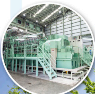
ガスコジェネレーションによる熱電供給
