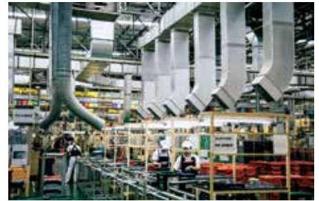
Hệ thống làm mát bằng hơi nước với tác động môi trường thấp của quạt để đạt được hiệu quả tự vận hành tốt nhất.
